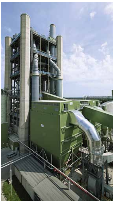
Entstaubungsanlage in der Zementindustrie.
